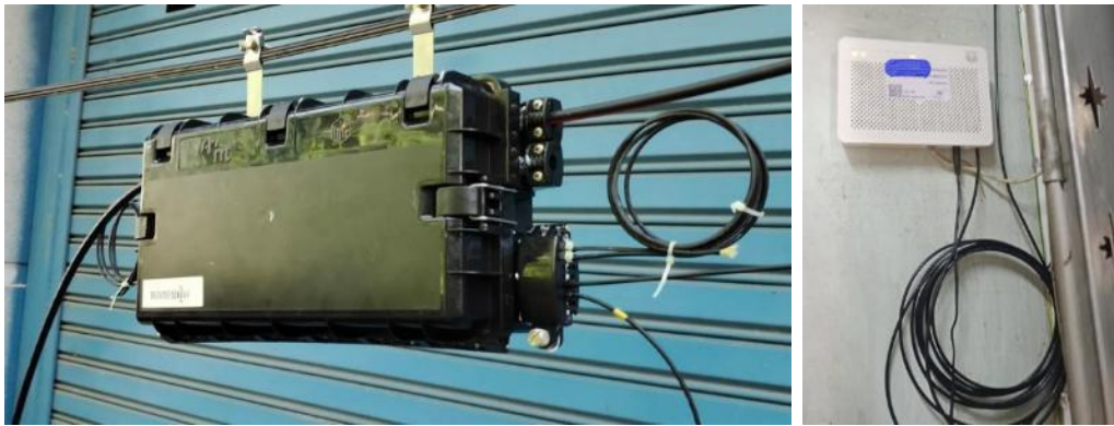
ภาพประกอบที่ 1. สาย OFTK เชื่อมต่อตำแหน่งตู้ SDP/ODP และตำแหน่งอุปกรณ์ ONU
