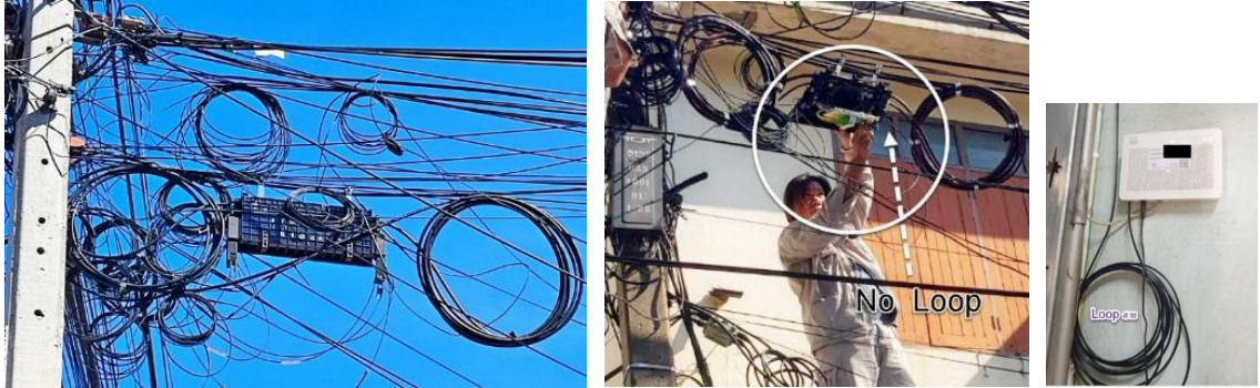
ภาพประกอบที่ 12. สาย Optic Drop Wire ตำแหน่งตู้ SDP ห้าม Loop สาย (ภาพกลาง)
