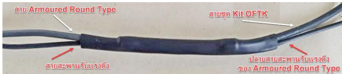
ภาพประกอบที่ 25. หุ้มรัดสายสะพานรับแรงดึงในท่อหุ้มสีดำจุดเชื่อมต่อเส้นใยแก้วนำแสง
